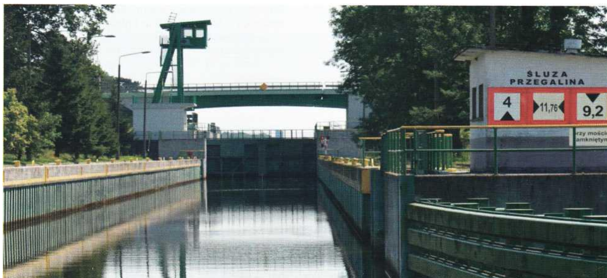
Śluza Przegalina - w głębi widoczny most drogowy zwodzony
