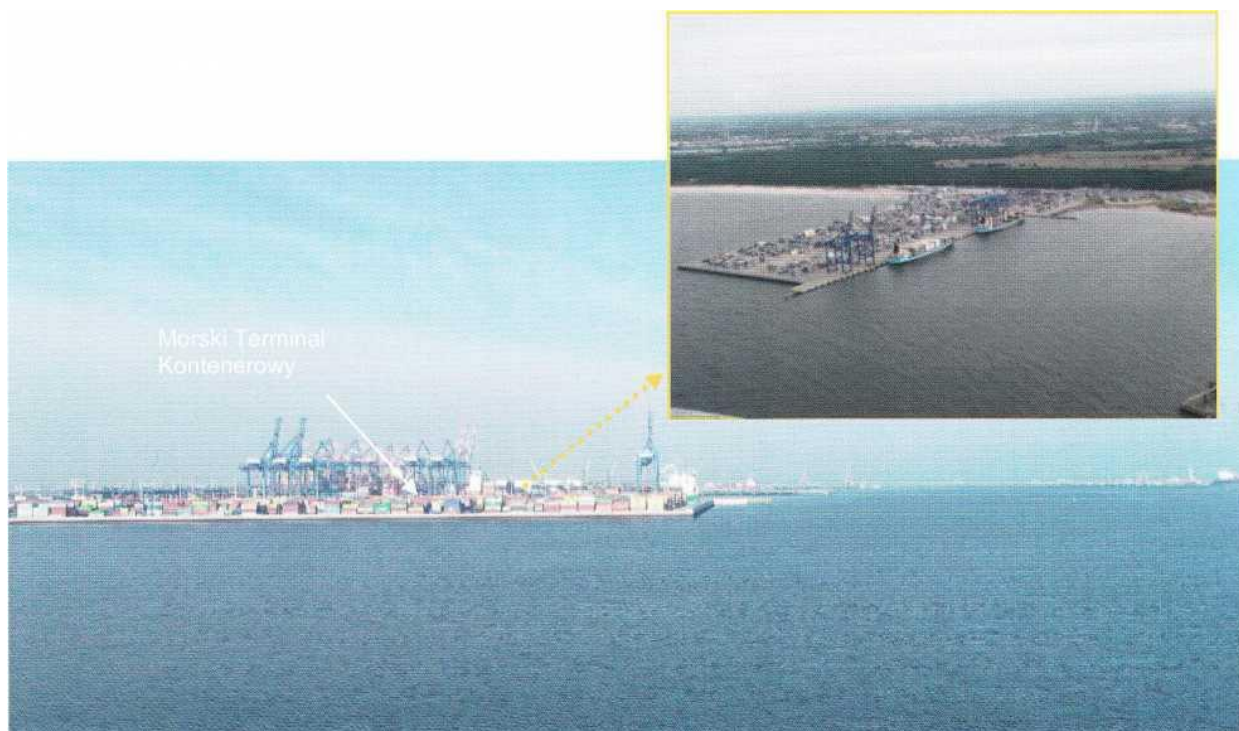
Port Północny – na wschód od wejścia głównego
