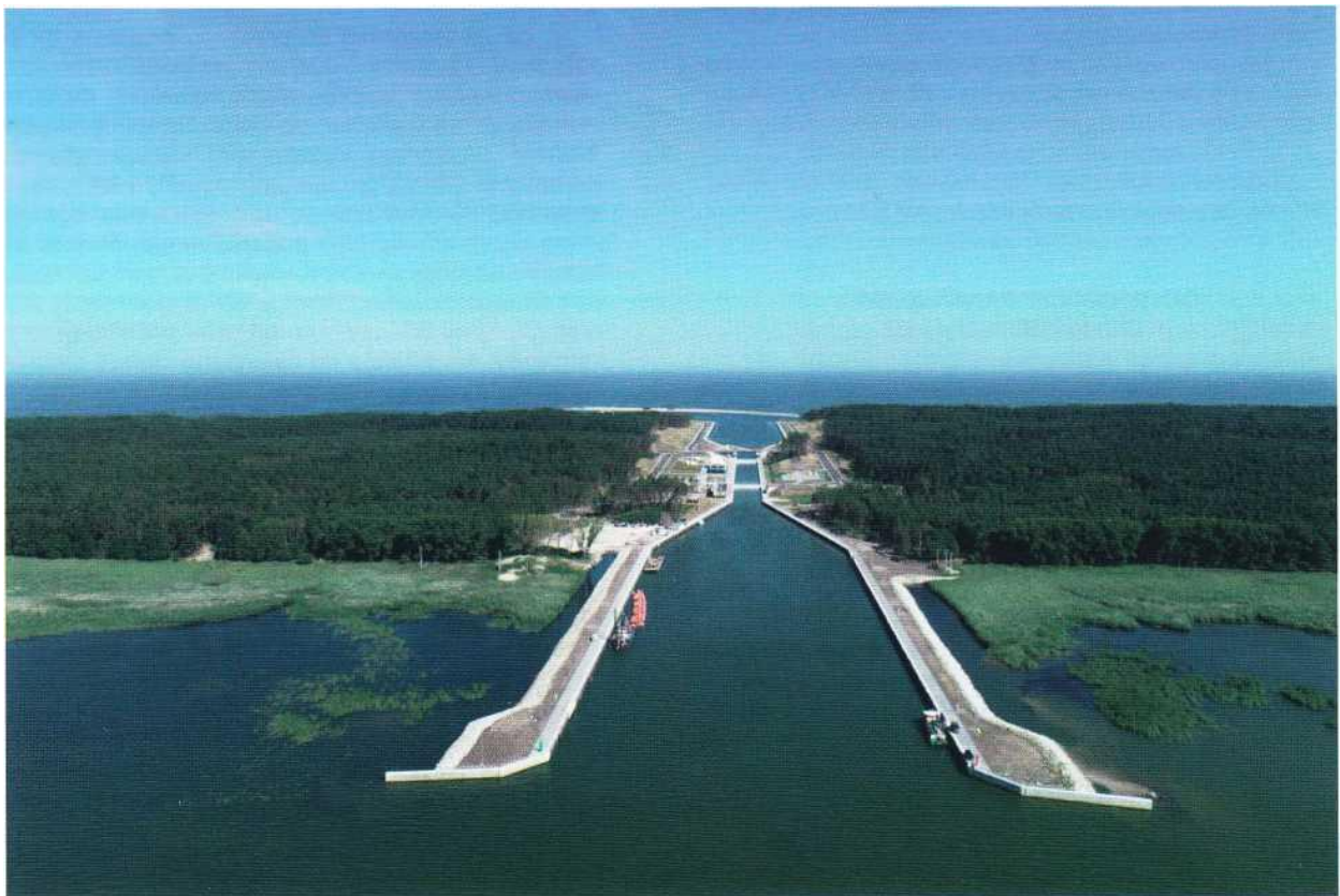
Przekop Mierzei Wiślanej - Nowy Świat - port - wejście od strony Zalewu Wiślanego
