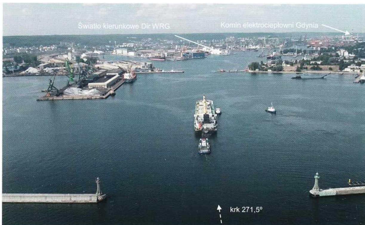
Gdynia – wejście główne
