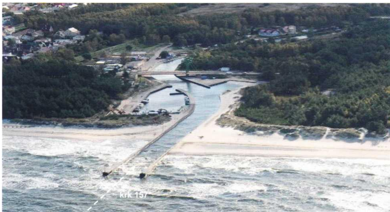
Dźwirzyno – wejście do portu
